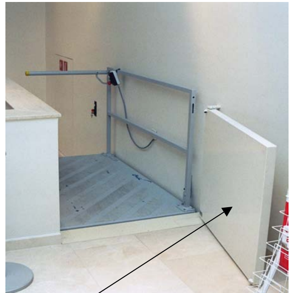
Tor oben manuell oder elektrisch (bauseitige Lieferung)
